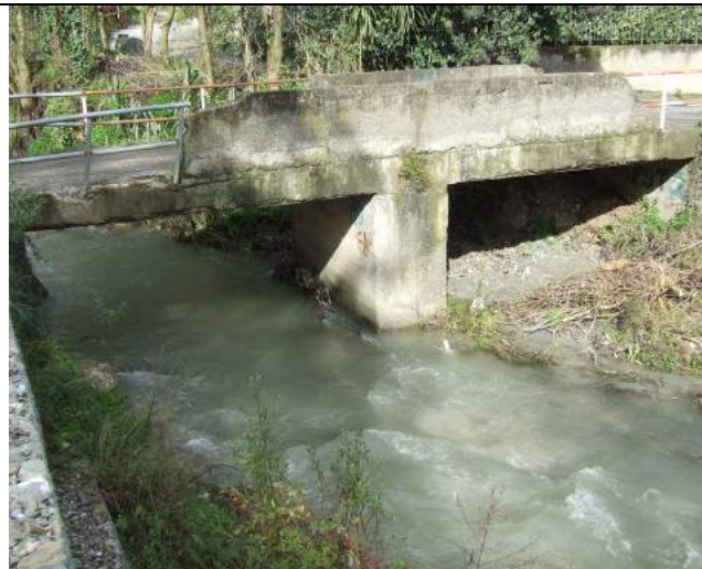
FOTO Passerella su Torrente Piazza loc.Calia vista lato valle
